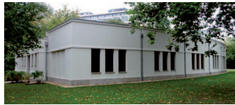
NÖFER ARCHITEKTEN, Elektronenmikroskopgebäude, TU Berlin
